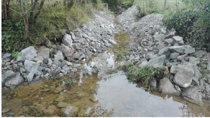
Fin de travaux
